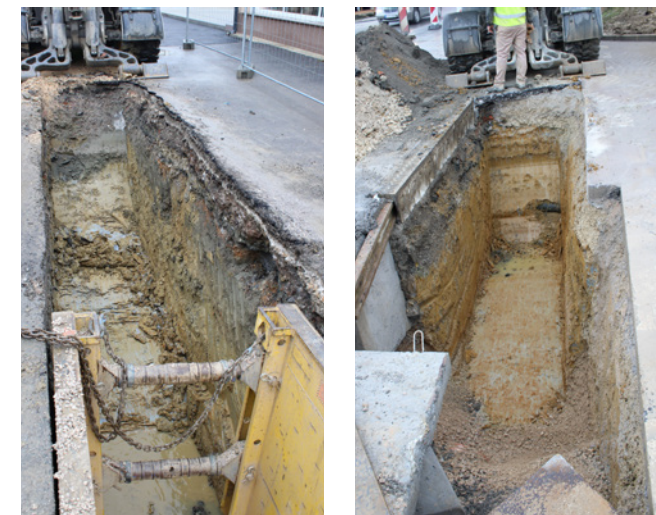
Dio iskopa na potezu nadzora u naselju Turanj, foto: Iva Alibašić
